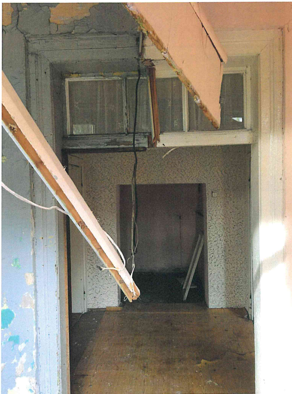
Fot/Rys - 5-3 – Uszkodzenie elementów stropu
