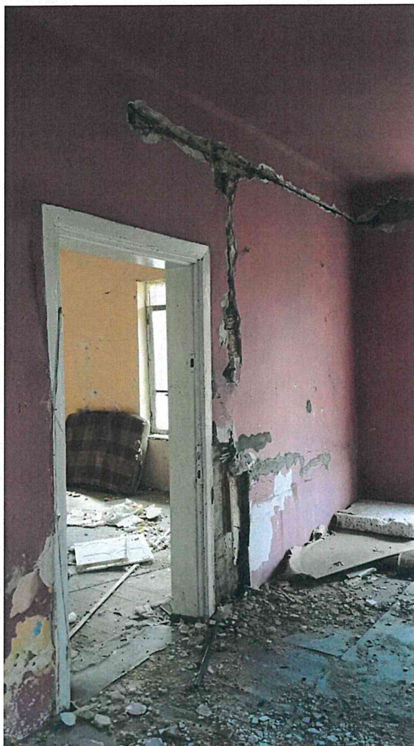
Fot/Rys - 5-1 – Uszkodzenie ścian drewnianych
