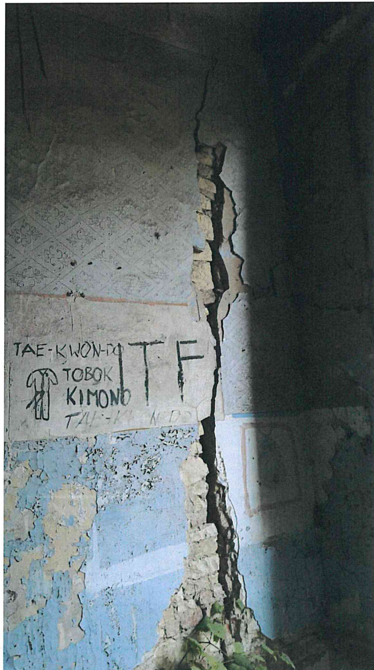
Fot/Rys - 4-18 – Spękanie naroży ścian murowanych
