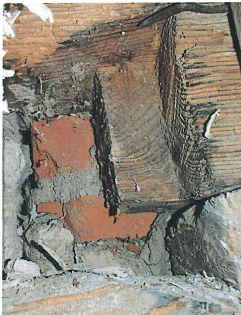
Fot/Rys - 6.2.4 Belki w starszej części gr ok 12cm widok uszkodzonego zamka, węgły z resztkami prawdopodobnie usunięto przy docieplaniu supremą.
