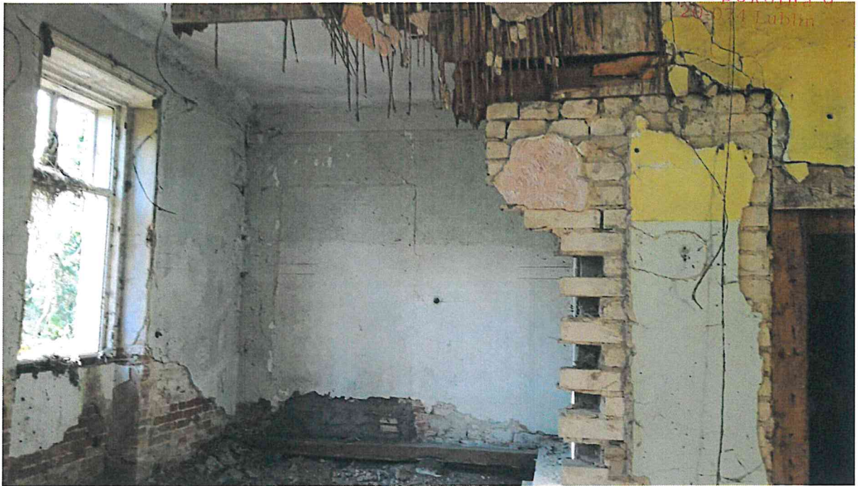
Fot/Rys - 4-15 – Uszkodzenie ścian murowanych
