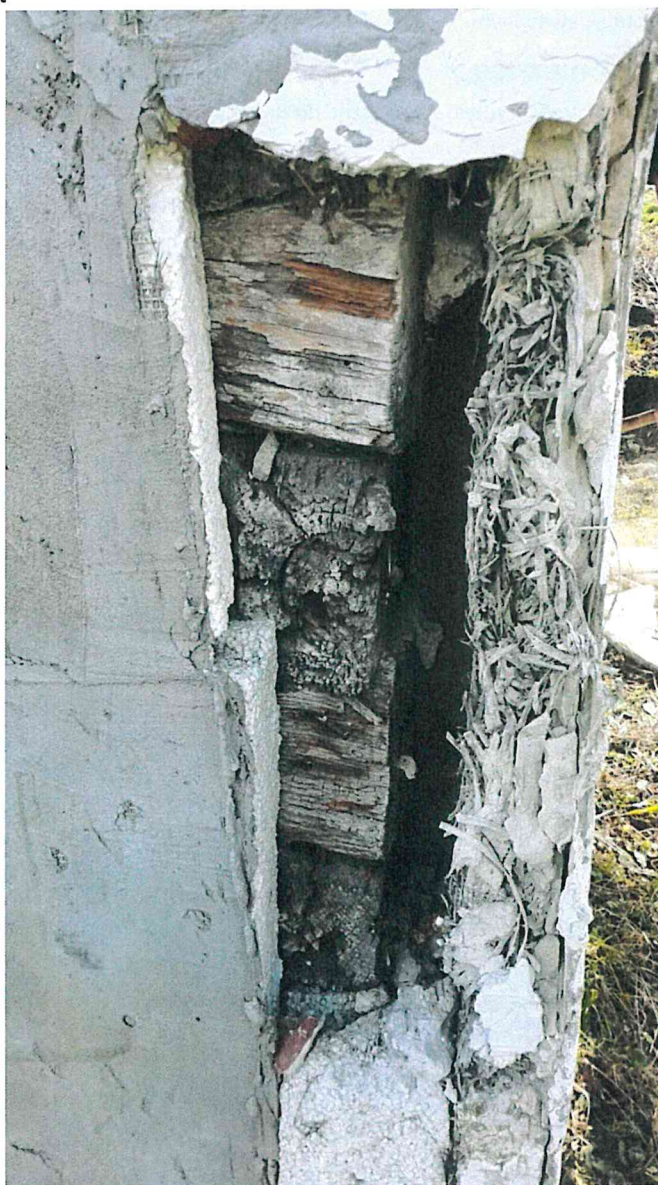
Fot/Rys - 8-2 – Odspojona okładzina.
