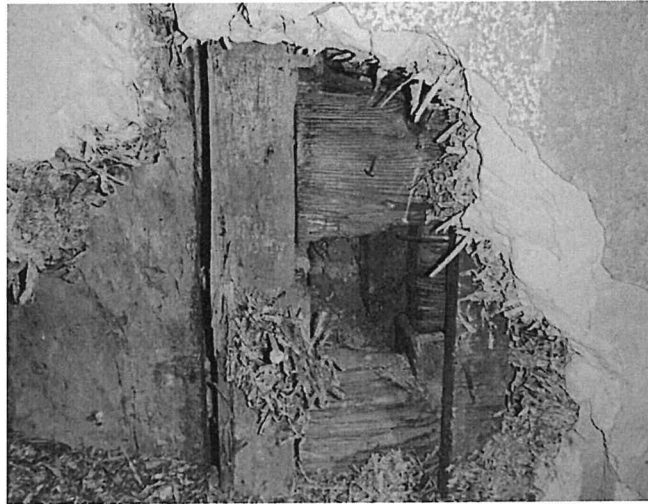
Fot/Rys - 6.2.2 Połączenia budynków po prawej uszkodzona konstrukcja węglów w narożniku, po lewej łątka w narożniku dobudowanej części budynku drewnianego
