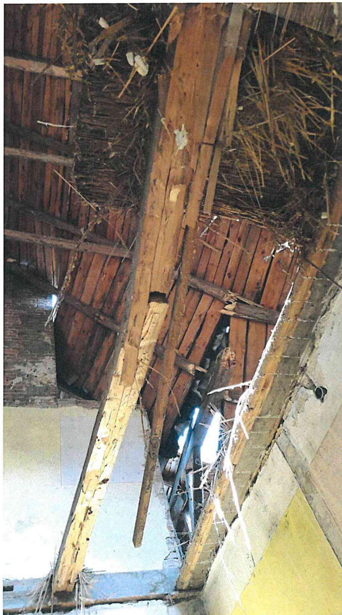
Fot/Rys - 4-17 – Ubytki w stropie/uszkodzenia elementów nośnych więźby dachowej
