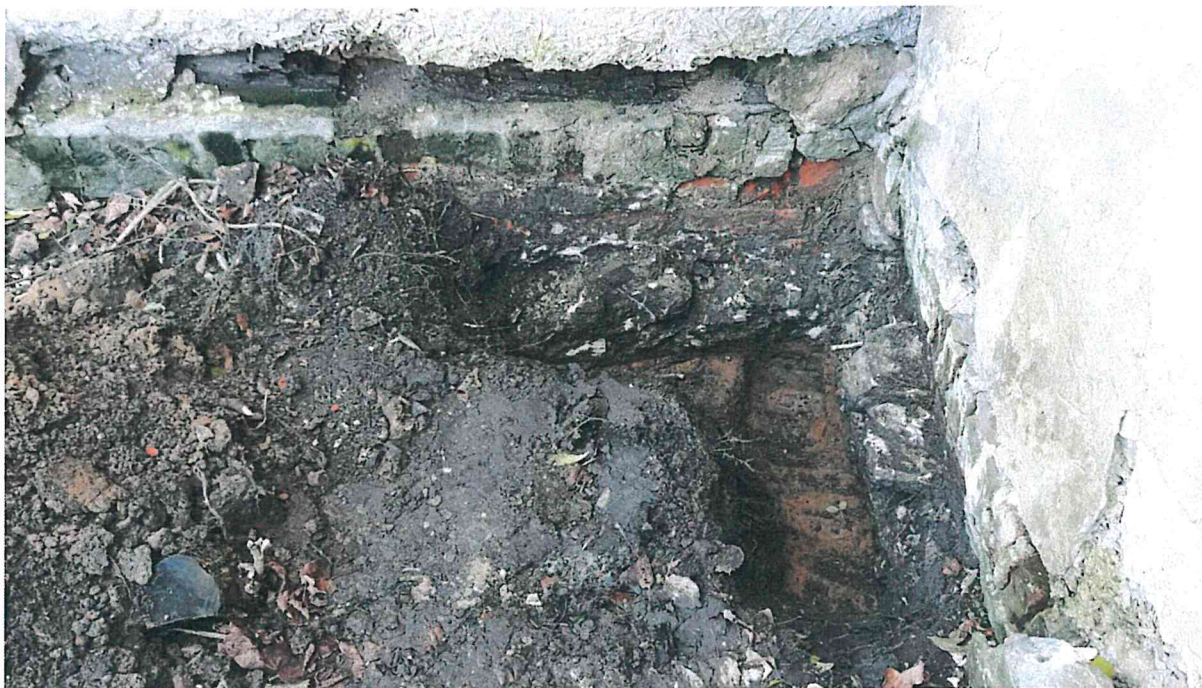
Fot/Rys - 3-4 – Odkrywka NR2 – stan zachowania fundamentu.
