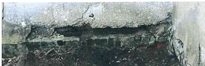
Fot/Rys - 8-1 – Uszkodzenie podwaliny.
