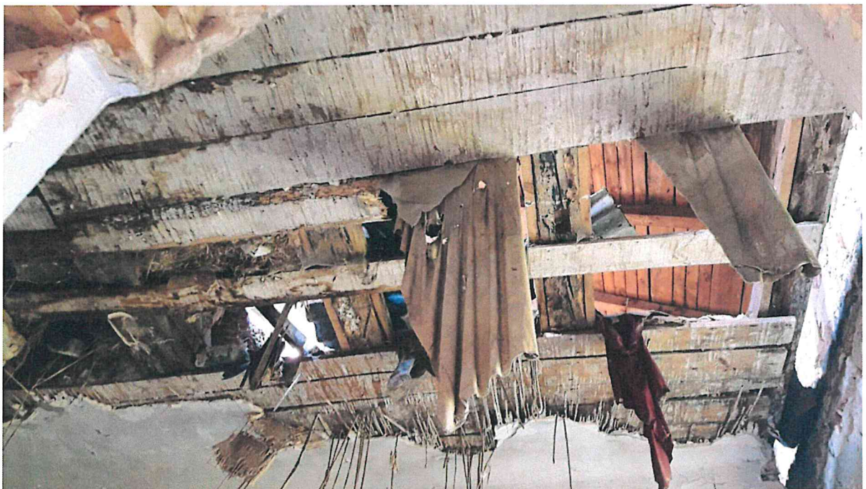
Fot/Rys - 4-16 – Ubytki w stropie istniejącego stropu
